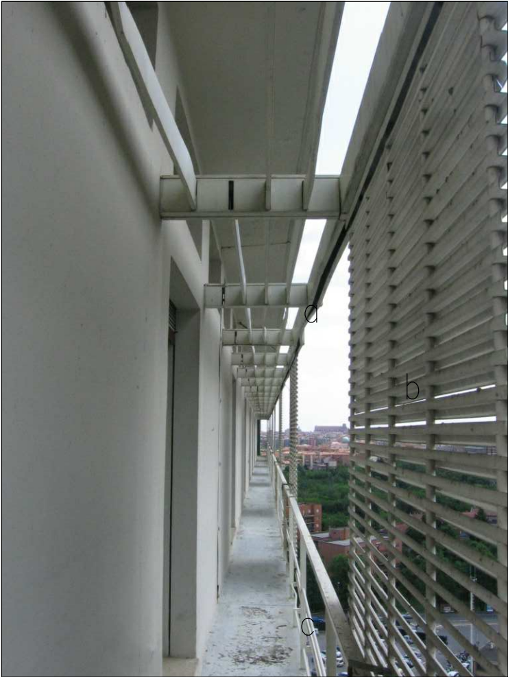
vista dall'esterno: frangisole esistenti da rimuovere (a+b); ringhiere da mantenere (c)
